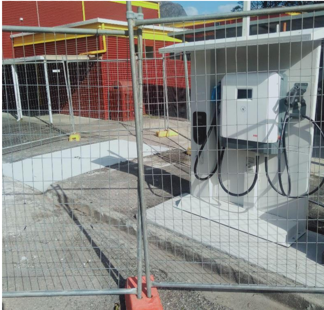
Tullah (EHT) – in build
